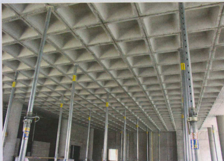
▲ Obr. 20. Kazetová stropní deska s dočasnými podporami při výstavbě
