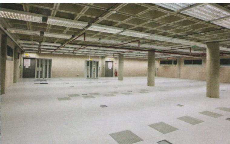
▲ Obr. 25. Sálové prostory se zvýšenou podlahou
