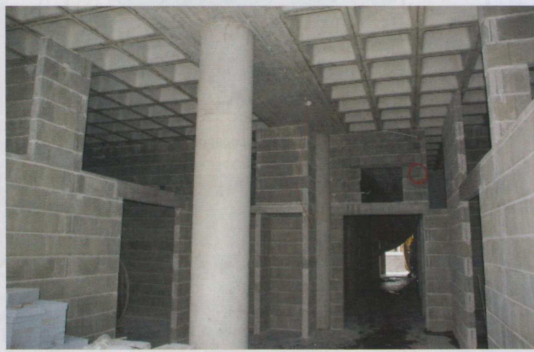
▲ Obr. 28. Vhodné použití zdiva Liapor s nároky na prostupnost technologických rozvodů
