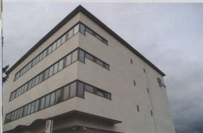
▲ Obr. 15. Pohled na dokončenou budovu Dátového centra Slovak Telekom v Bratislavě
