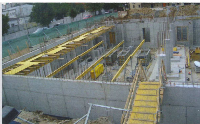
▲ Obr. 27. Pohled na základovou konstrukci se suterénními stěnami
