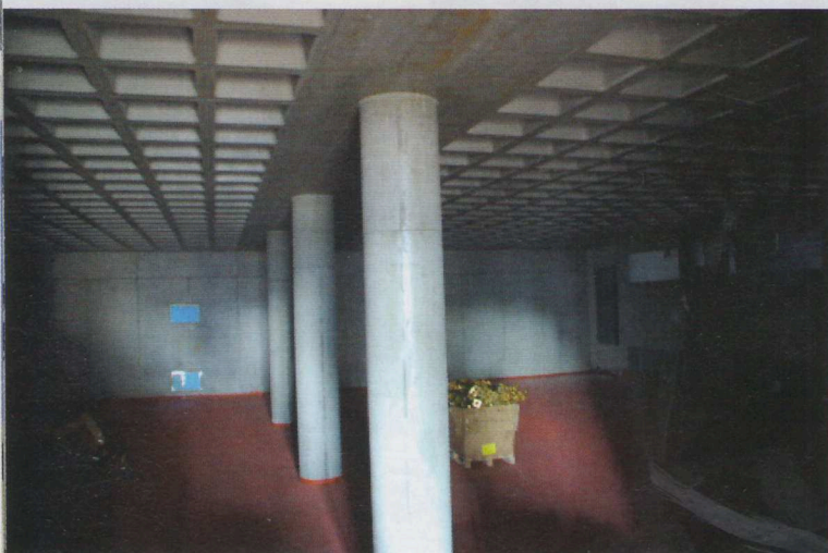
▲ Obr. 26. Skryté deskové průvlaky kazetových stropních desek
