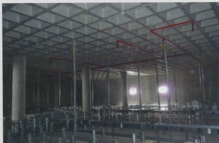
▼ Obr. 24. Montáž zvýšené podlahy v sálových prostorech
